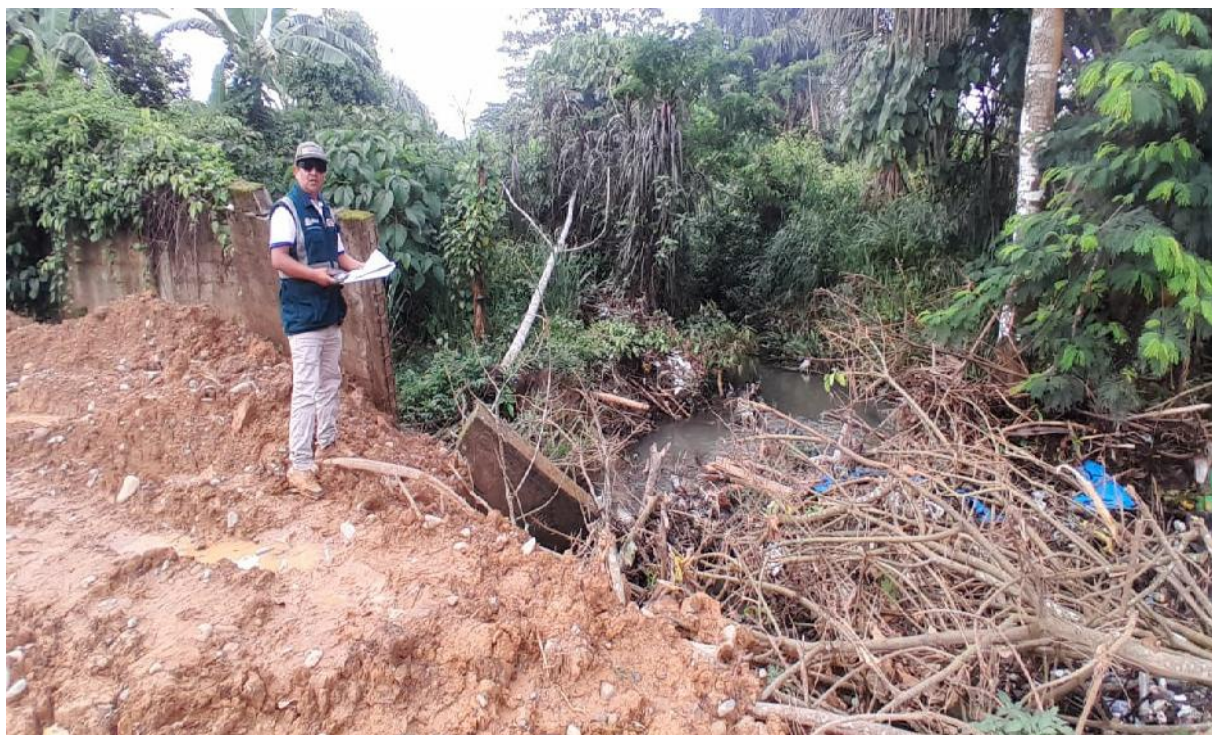
FIGURA N° 02: SE APRECIA SOCAVACIÓN Y DERRUMBE DE CERCO PERIMETRICO DE VIVIENDA MARGEN DERECHA DE LA QUEBRADA CHAUPIMAYO
